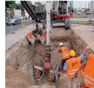
Gebündelte Energie: 6 Leitungen für 2 x 110 kV. Verlegt werden Kabel für die doppelte Leistung.
