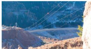
325 m Spannfeld: die immense Zug-Belastung kann durch Eislasten drastisch erhöht werden
