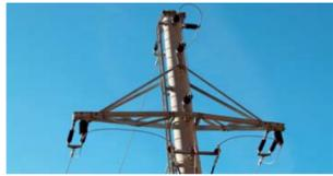
Eine Ing. Viktor Müller-Erfindung: Obergurte am Strommast erhöhen die Lotlasttragkraft
