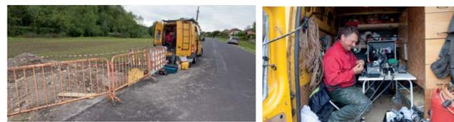
Mobiler Arbeitsplatz: bei unsicherer Wetterlage wird im Auto gespleißt. Regen oder kalte Finger sind beim Lichtwellenleiter-Spleißen kontraproduktiv.
