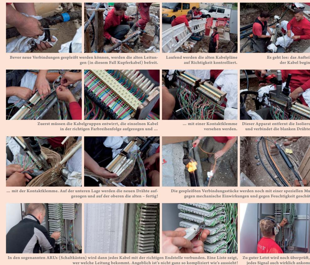
Bevor neue Verbindungen gespleißt werden können, werden die alten Leitungen (in diesem Fall Kupferkabel) befreit. Laufend werden die alten Kabelpläne auf Richtigkeit kontrolliert. Es geht los: das Aufteilen der Kabel beginnt.
