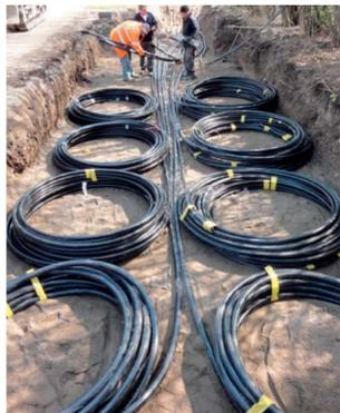
Die Breiten der Künetten bei der Umverlegung der Versorgungsleitungen in Deuchendorf übertreffen sogar noch jene des Erzberges.
