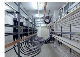
Das Ersetzen der alten Kupferteknik durch die neue Lichtwellenleitertechnik bringt neben wirtschaftlichen (größere Datenübertragungsraten bei geringeren Produktionskosten) auch noch anderen Vorteile (keine Beeinflussung mehr durch Blitzschläge, viel geringerer Platzbedarf)! Technik, die früher in großen Räumen untergebracht wurde, hat nun in kleinen Metallkästen Platz (Bild rechts).
